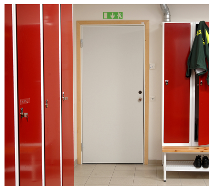
Massivdörr med laminatyta och plastkantlist i omklädningsrum
